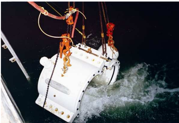
36" (DN 900) Reparaturklammer (mechanisch) für den Betrieb von Erdgasleitungen bei 69 bar
