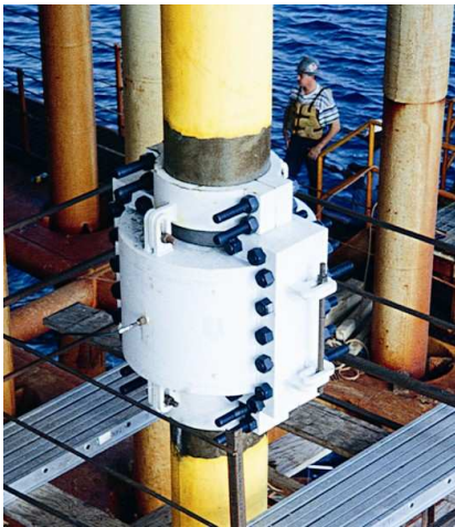
20" (DN 500) ANSI 600 Flansch-Verschlusskupplung, montiert an Offshore-Steigrohren, die Erdgas bei 1100psi (75 bar) transportieren
