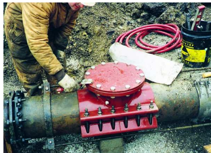
12" (DN 300) mechanisches Linestop-Fitting mit Blindflansch
