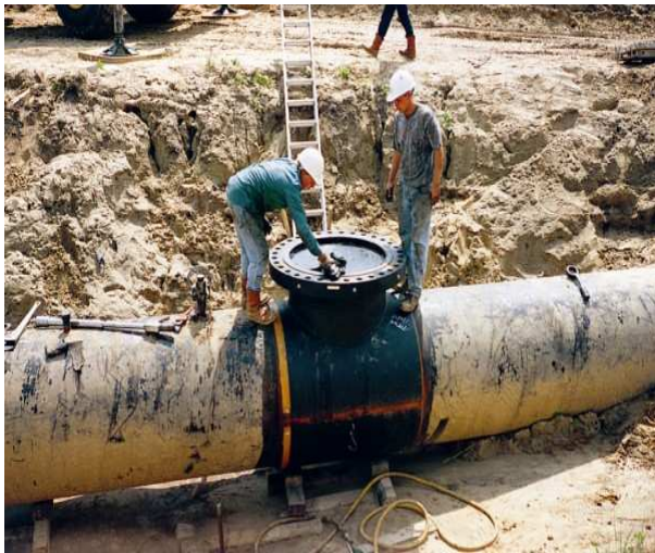
48" (DN 1200) Linestop-Fitting mit Verschlusskappe montiert an einer Erdölpipeline
