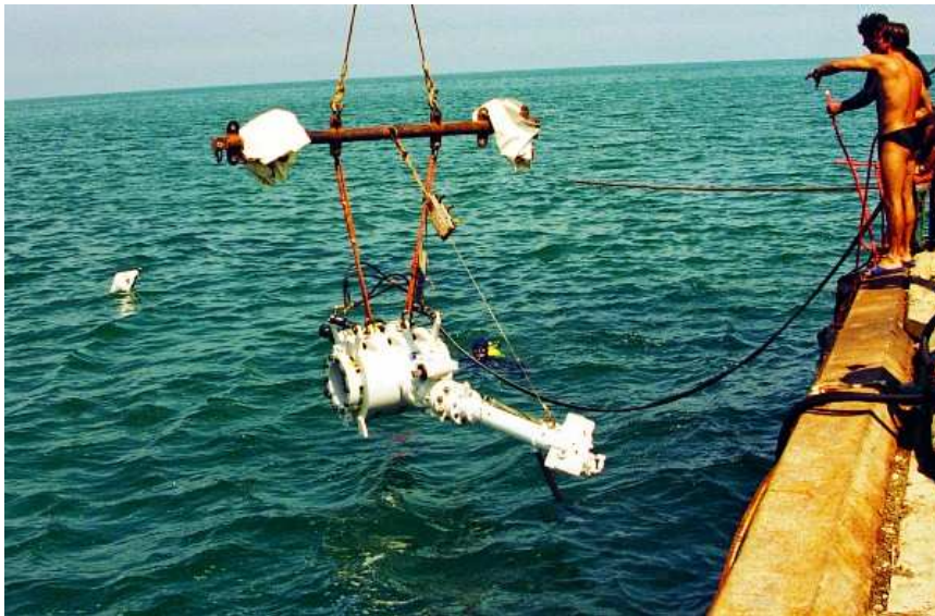
Mechanisches Anbohr-T-Stück mit montierter Anbohrmaschine wird in den Golf von Mexiko herabgelassen zwecks Klammermontage und Durchführung des Hot-Tap-Verfahrens
