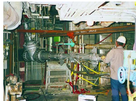
8" (DN 200) HTP-Absperrung bei 29 bar und 370°C in einem Dampfcondensatrohr einer Papiermühle
