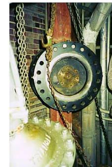
8" (DN 200) HTP-Absperrung bei 29 bar und 370°C in einem Dampfcondensatrohr einer Papiermühle
