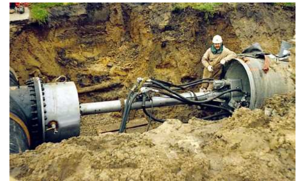
Anbohrung DN 900 an einer Wasserleitung
