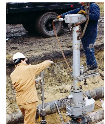
Anbohrung DN 900 an einer Wasserleitung
