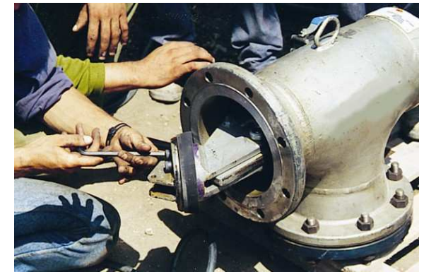
Vorbereitung eines Absperrkopfs DN 200
