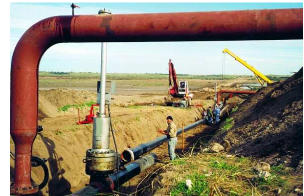
Absperrung DN 350 mit Bypass
